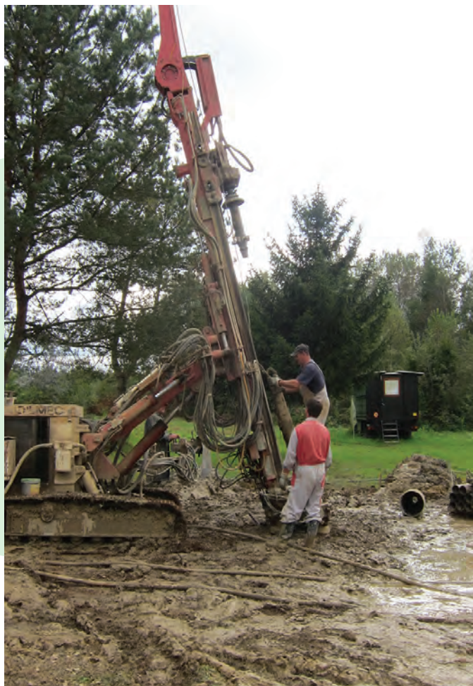
Vrtanje v globino 20 m za namestitev pilotov za temeljenje točke Prilozje
