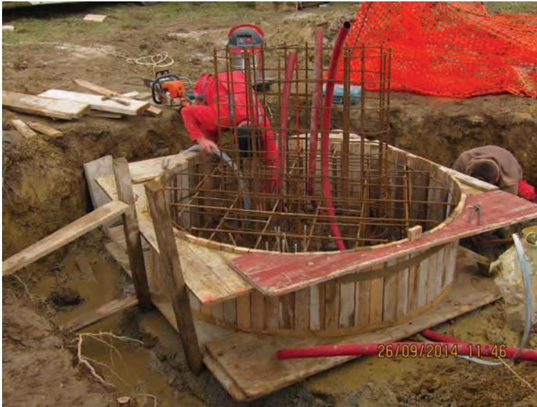
Betoniranje temelja in stebra točke Prilozje
