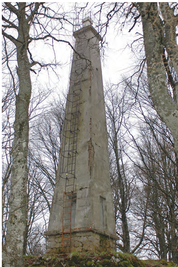
Steber trigonometrične točke I. reda na Trdinovem vrhu
