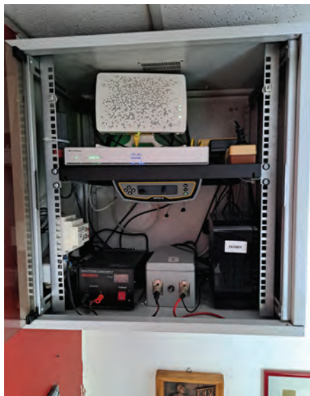
Razporeditev naprav v omarici stalne postaje GNSS v Črnomlju
