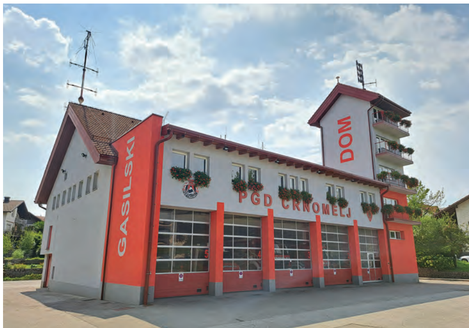
Stavba PGD Črnomelj, kjer je na strehi stolpa antena stalne postaje GNSS v Črnomlju
