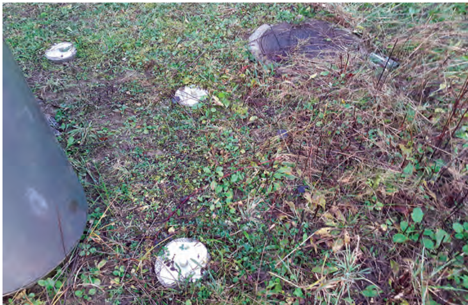
Tri talne točke na temeljni plošči točke Prilozje (v ograji)
