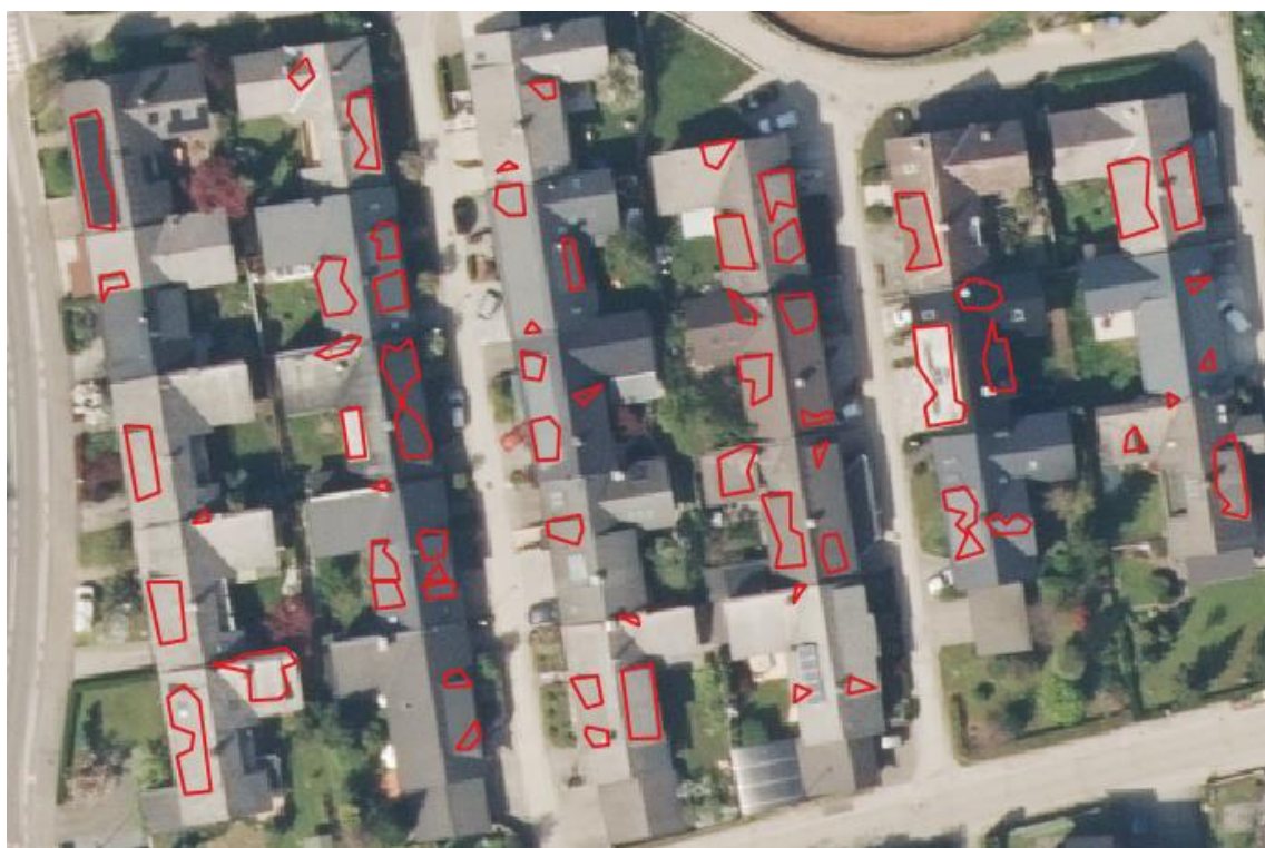
Slika 32: Test avtomatskega zajema frčad – rezultat avtomatskega zaznavanja so frčade obkrožene s poligoni
