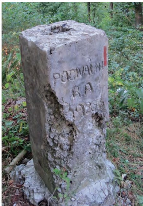
Ohranjena italijanska trigonometrična stebra s štirikotnim presekom na Počivalniku (721 m) iz leta 1926 in s šestkotnim presekom na Babi (1085 m) iz leta 1936
