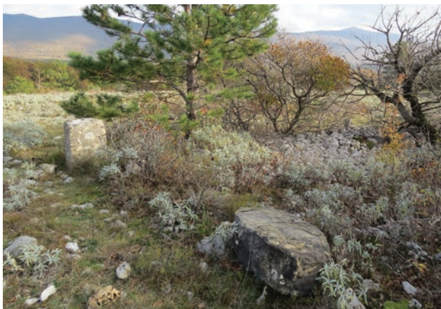
Vrh Soligrad: levo je italijanski medvojni betonski trigonometrični steber s kvadratnim presekom, ki je danes trigonometrična točka 42-IV-18, desno spodaj pa je izpuljeni mejnik iz peščenjaka.
